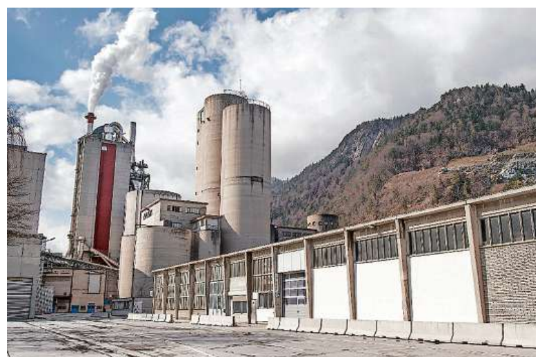
Beindruckend: Das Zementwerk Untervaz wurde im internen Leistungsvergleich nur von einem amerikanischen Werk geschlagen. (FOTO OLIVIA ITEM)
